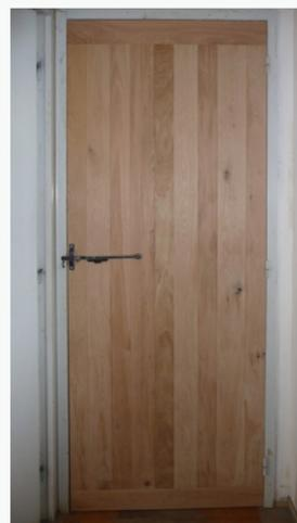
Traditionnellement les portes étaient constituées de lames de différentes largeurs avec des fermetures par loquets poucier. Nous avons adapté ce style de porte à des intérieurs chauffés. Les portes sont assemblées avec 2 ou 3 « clés » à l'intérieur qui permettent de garantir une grande stabilité de l'ensemble.
